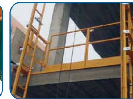
Puerta en planta Floor door
