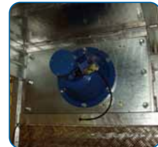
Freno paracaídas de emergencia Overspeed emergency brake
